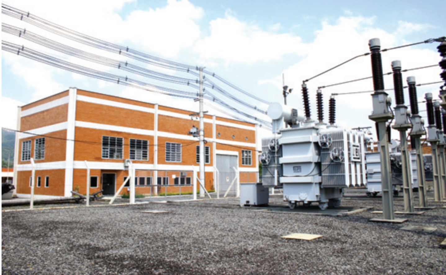
↳ Laboratório (esq.) fica ao lado da subestação de energia (dir.), no Parque Fabril II
