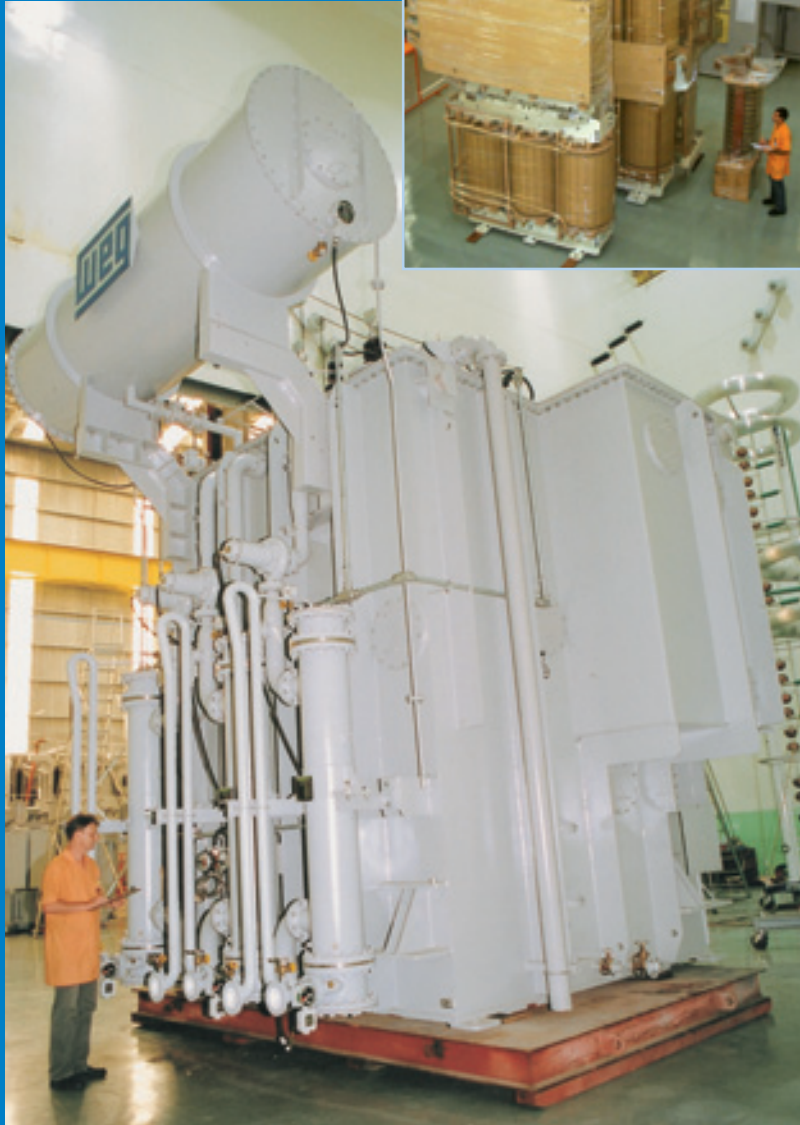
Transformador retificador tem 4,90 m de altura e 136,7 toneladas
