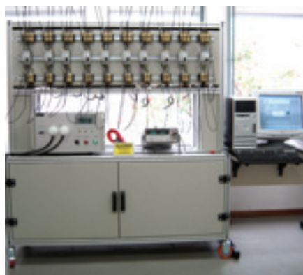
Desempenho do disparo térmico do disjuntor
