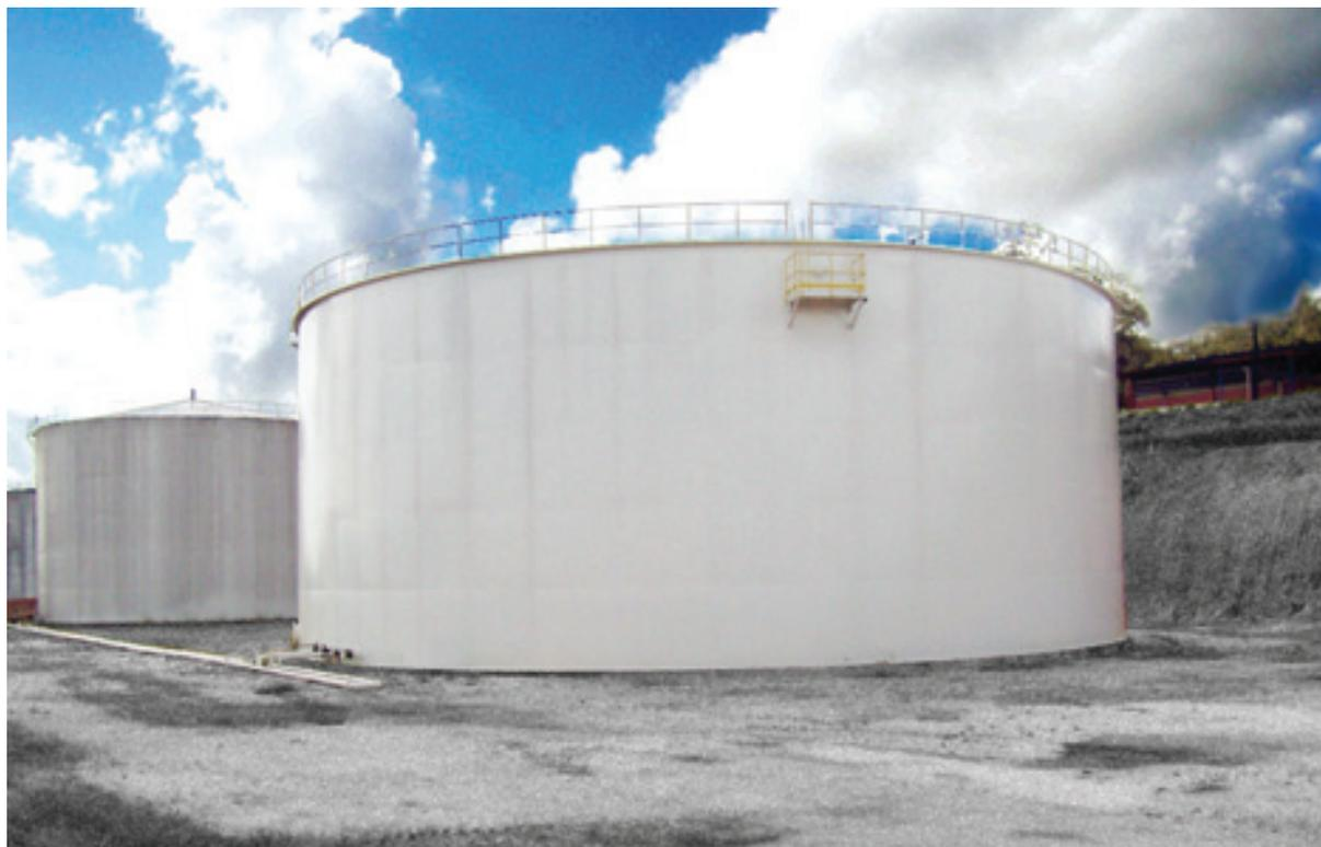
Tanque da Destilaria Giasa pintado com tinta antifungo; ao fundo, tanques sem tinta antifungo
