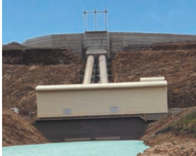
A economia de energia obtida com motores mais eficientes é um potencial que supera a participação das Pequenas Centrais Hidrelétricas, como essa da foto, no balanço energético nacional
