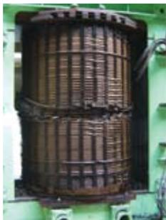
Desmontagem e avaliação na UHE GBM - falha no enrolamento de alta tensão 550 kV
