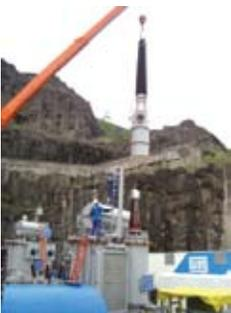
Montagem do arranjo SF6 para ensaios elétricos de alta tensão na UHE GBM
