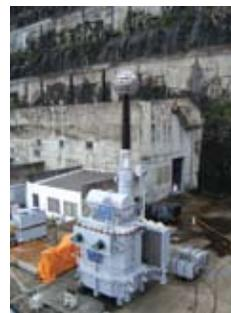
Primeira unidade sob ensaios elétricos de rotina e especiais na UHE GBM
