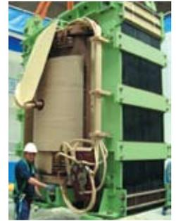
Parte ativa após reforma na UHE GBM
