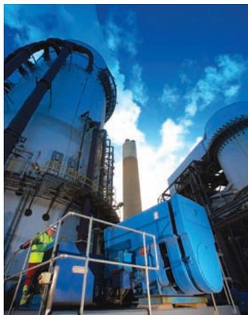
Bomba de recirculação, utilizada para transferir a suspensão de calcário para o topo das torres da unidade de dessulfurização
