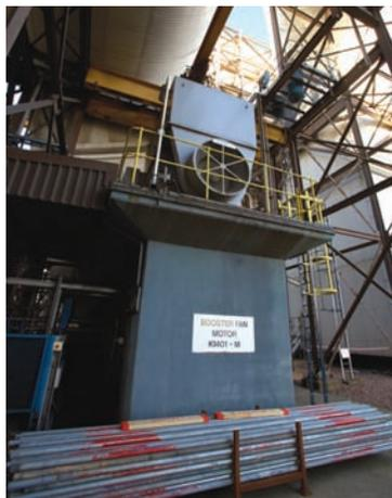
Ventilador para empurrar os gases através da instalação
