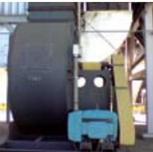
Motores instalados em ventiladores, de 60 cv (acima) e 200 cv (abaixo)
