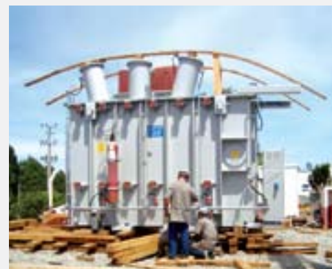
Instalação de transformador WEG na subestação da BRF
