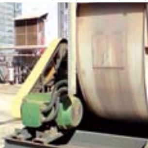
Motores instalados em ventiladores, de 60 cv (acima) e 200 cv (abaixo)
