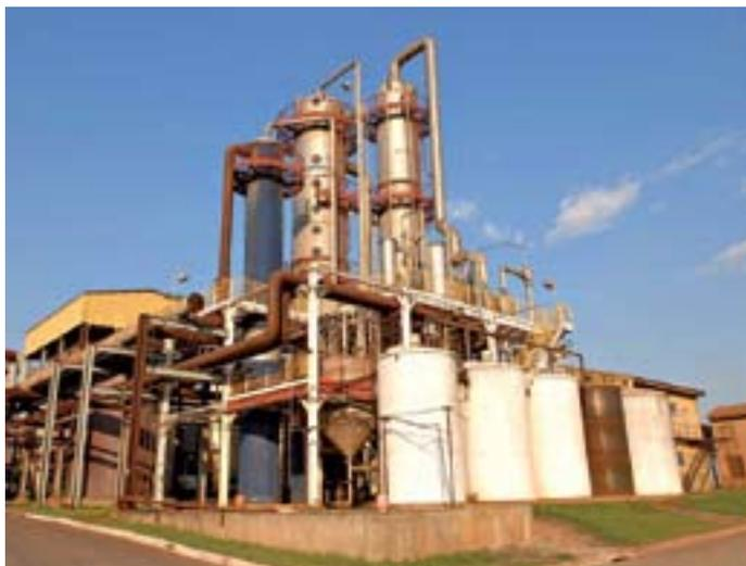
As três colunas de destilação
