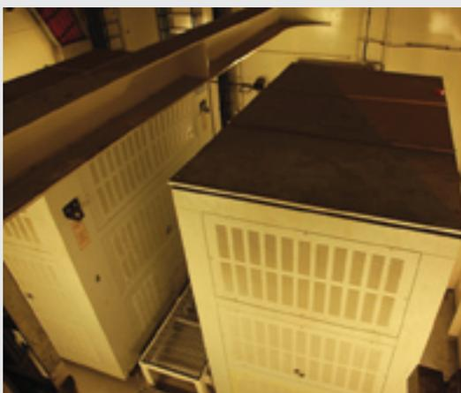
*Transformadores a Seco WEG instalados na casa de máquina da P-57*
