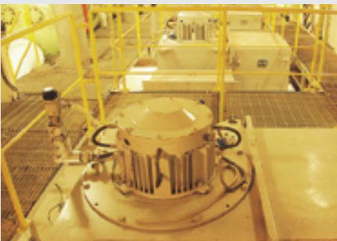
À esquerda, motores elétricos MGW500 – 950KW do sistema de elevação de água.
