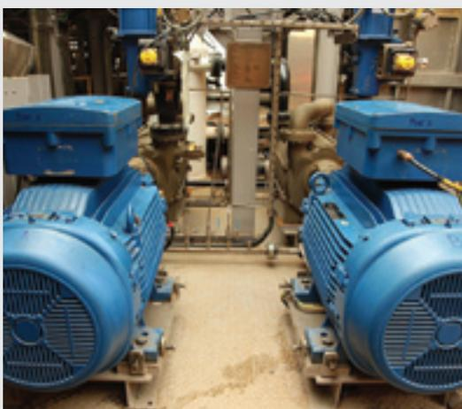
*Motores WEG de baixa tensão a prova de explosão aplicados em bombas do processo*
