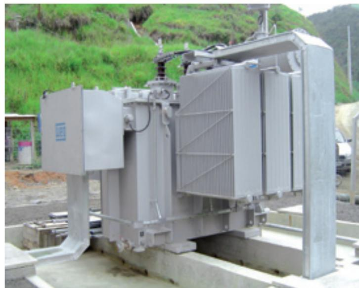
Transformador Elevador recebe energia elétrica e a transforma em alta tensão
